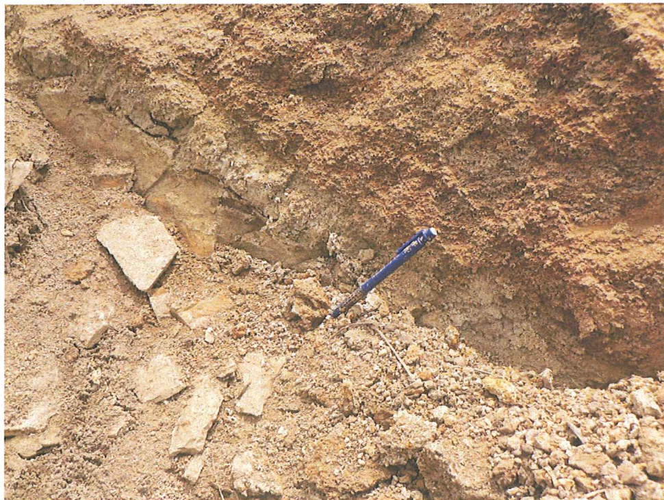
Plate TF8. Chn.19.5m. Narrow clayey zone (pale grey), immediately above the fault plane.
